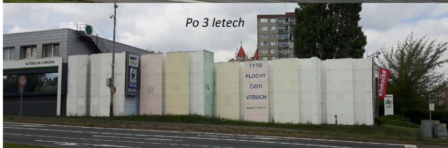
▲ Samočisticí ochranný efekt na renovovaných Barrandovských zvukových bariérách vedle autosalonu Klokočka je po třech letech naprosto zřejmý každému, kdo projíždí okolo. Nenanatřená místa jsou zašpiněná, ošetřená mají původní vzhled. Navíc, jak ukázala nedávná open access studie Akademie věd v jednom z nejprestižnějších vědeckých periodik Applied Catalysis B: Environmental ( https://doi.org/10.1016/j.apcatb.2017.06.009 ), tyto bariéry denně vyčistí takové množství vzduchu, které stačí více než 250 lidem na celý rok.
