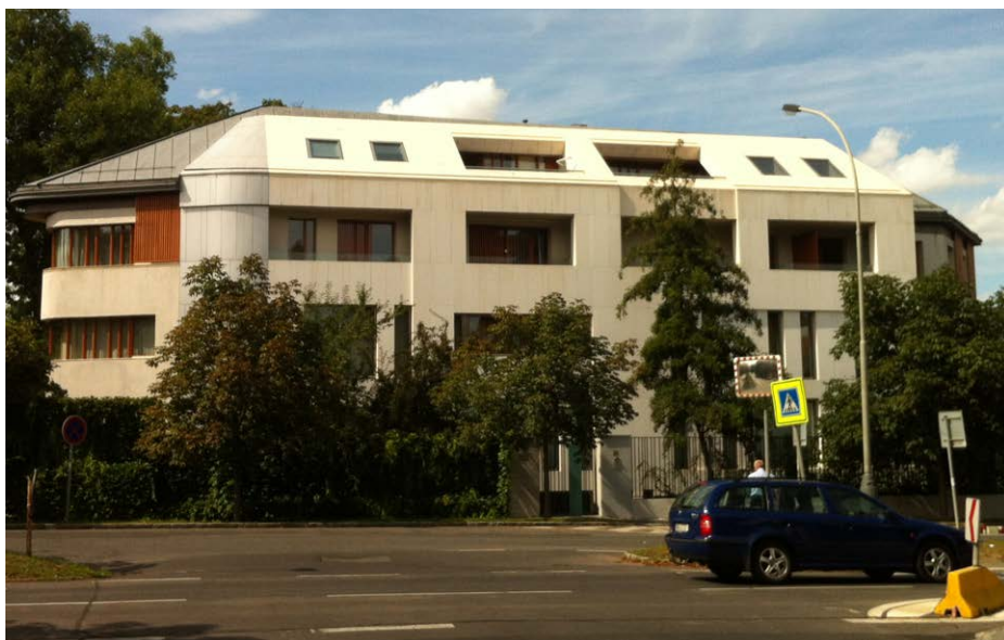
▲ Villa Bianca si na frekventované komunikaci díky samočisticímu efektu Protectam FN1 a FN2 i po téměř šesti letech zachovává zcela bílý vzhled.
